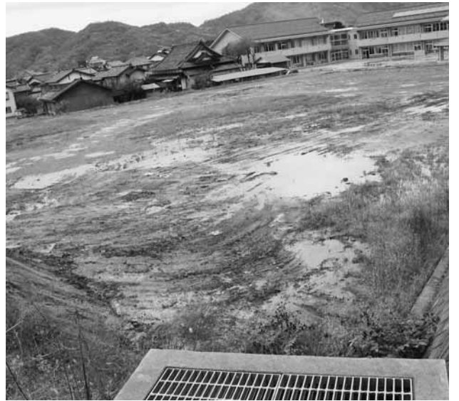
▲船岡小学校プール建設予定地
